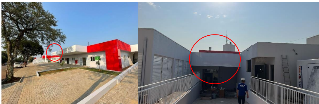
Figura 04 – Fotos das extensões das coberturas, já instaladas.
