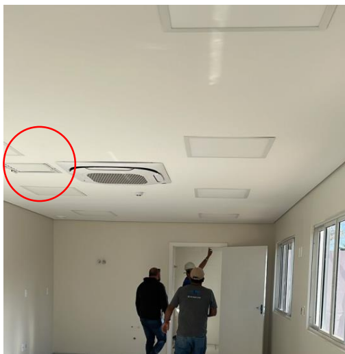
Figura 12 – Foto da portinhola do ar condicionado
